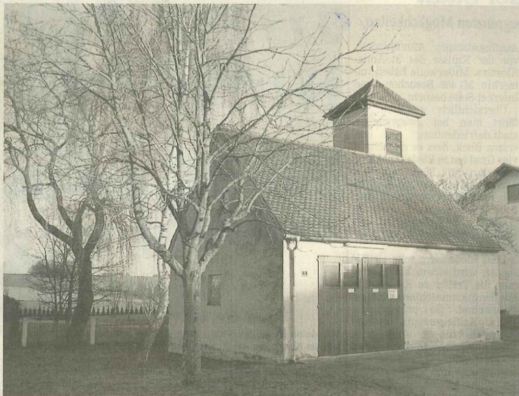
Das Feuerwehrhaus in Aschbuch soll einem Neubau weichen.
